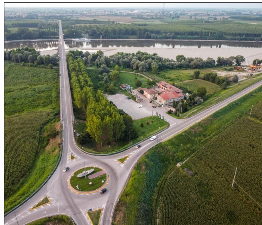
Ponte Boretto - Viadana
